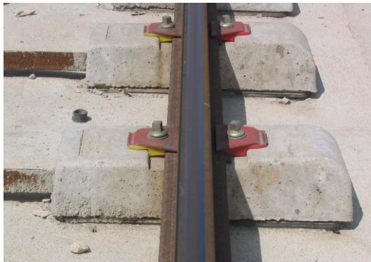
Figura num. 4: Detalle de sujeción de vía en placa
