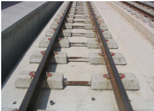
Figura num. 3: Fotografía de vía en placa
